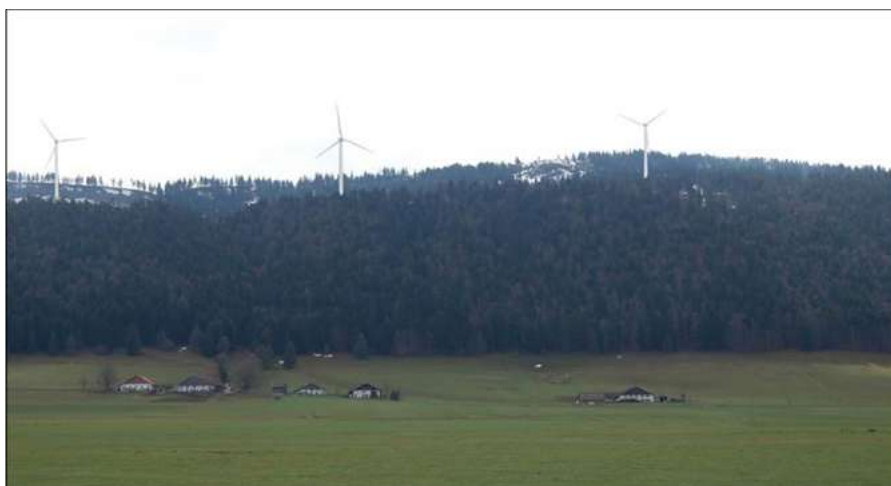
Figure 11 : Bâtiments dominés par les éoliennes : situation à éviter
